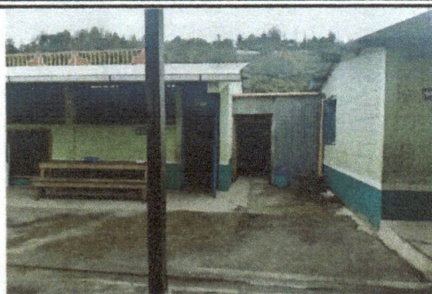
Foto 1: MODULO 1: Continuidad de paredes, cubierta de lamina y colocacion de canales pluviales de aula de preprimaria, para tener un mejor espacio
