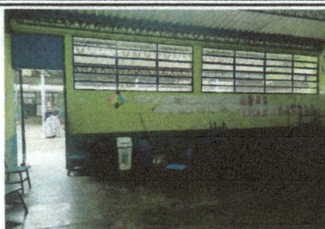
Foto 2: MODULO 1: Reestructuración de pared de aula de preprimaria con la intención de tener un mejor espacio para atender a los niños. Incluyendo puerta nueva, ventanales y sistema eléctrico
