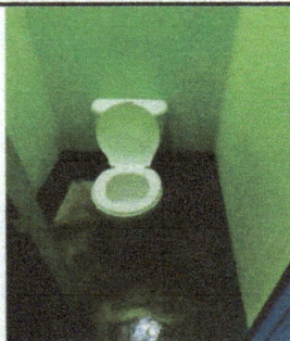
Foto 5: MODULO 4. Sustitución de 2 sanitarios.
